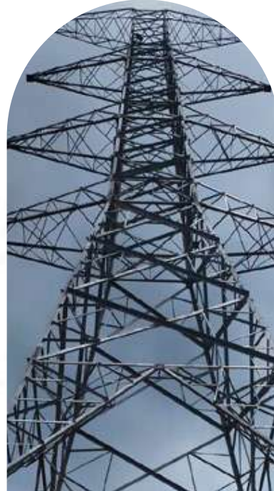
TOWER 500KV SUMATERA SELATAN
