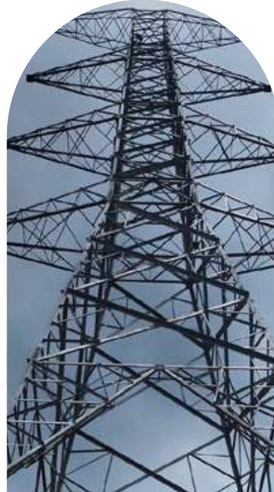
TOWER 500KV SUMATERA SELATAN
