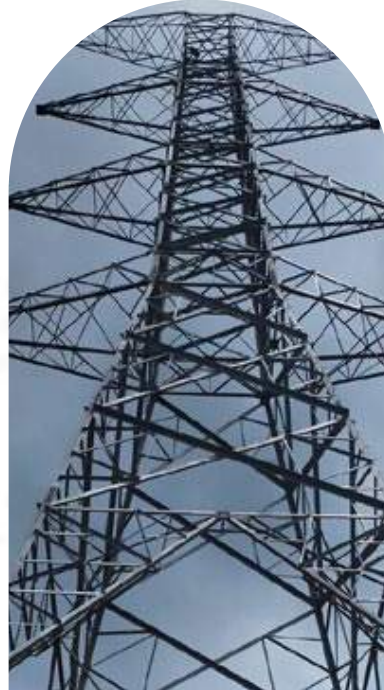
TOWER 500KV SUMATERA SELATAN
